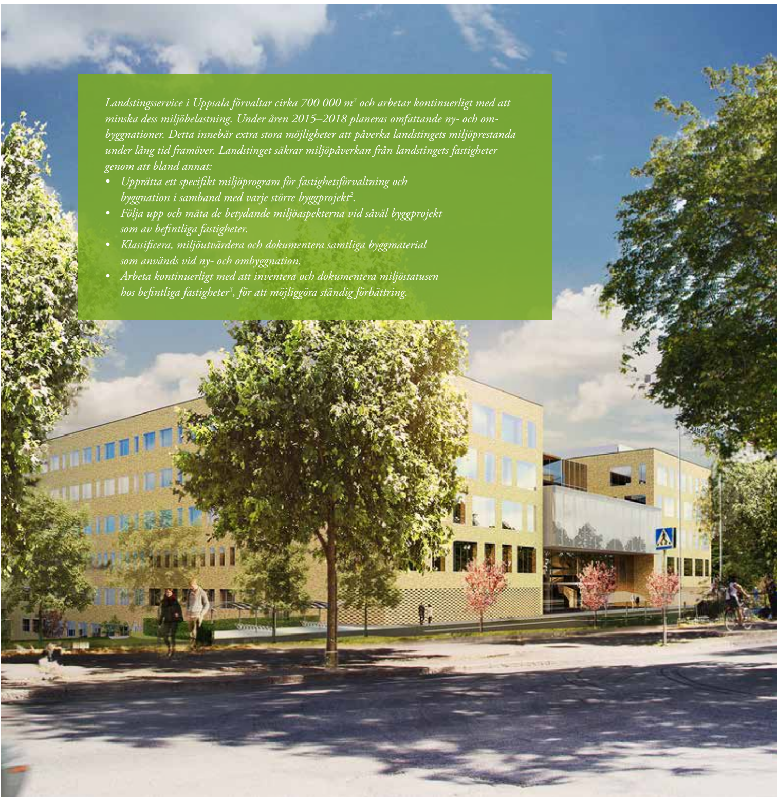
J-huset, Ingång 100, Akademiska sjukhuset – med miljöbyggnad, guld.
